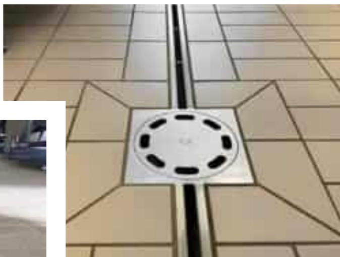
CANAL RANURADO CON SUMIDERO CON DESCARGA VERTICAL
