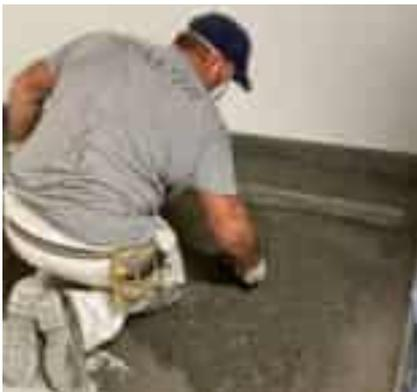
**3-** Colocación de la masa con sistema fresco sobre fresco y creación de las pendientes.
