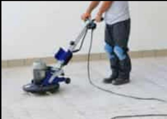
4-Aplicación del FullJoint en el interior de las juntas para el relleno total;
