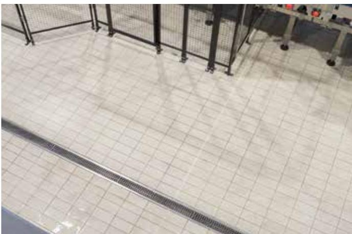
CANALE GRIGLIATO CON POZZETTO CON SCARICO VERTICALE
