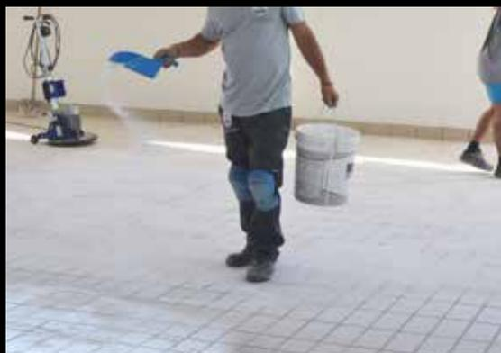
**3-** Seconda stesura dello strato di quarzite a spolvero;
