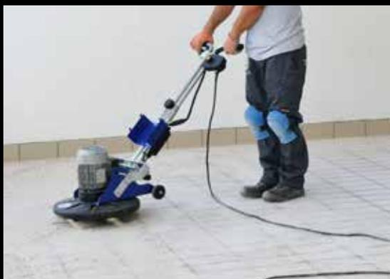
4-Spalmatura del FullJoint all'interno delle fughe per un riempimento totale;
