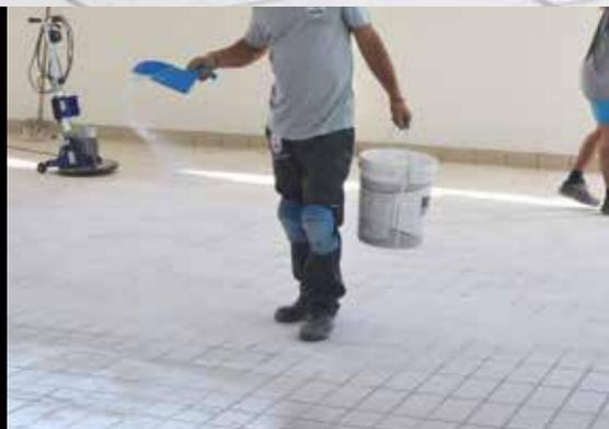
**1-** Stesura del primo strato di quarzite all'interno delle fughe;
